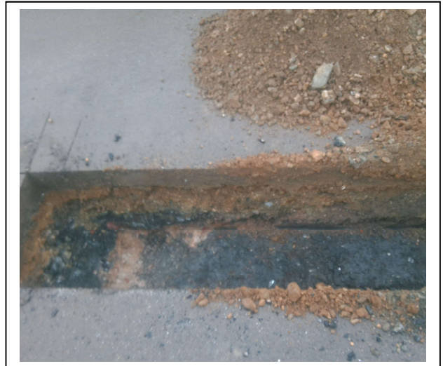
Foto 4. Sleuf D1.02 (23-50 cm -mv)
