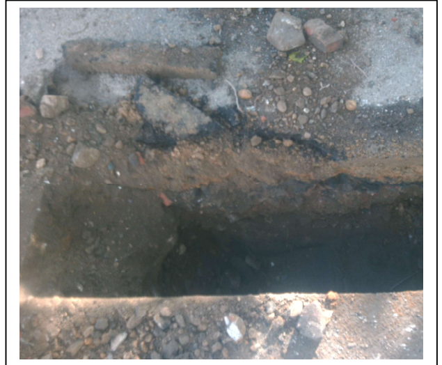
Foto 14. Sleuf D2.02 (25-50 cm -mv)
