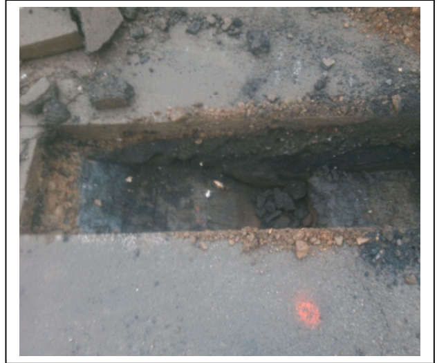
Foto 2. Sleuf D1.01 (10-40 cm -mv)
