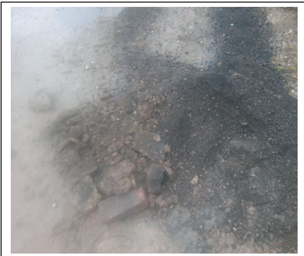
Foto 5. Sleuf D1.03 (0-20 cm -mv)
