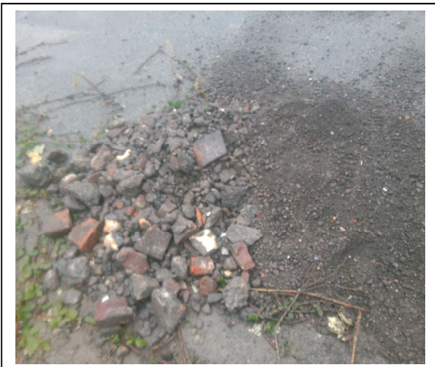
Foto 9. Sleuf D1.05 (30-50 cm -mv)
