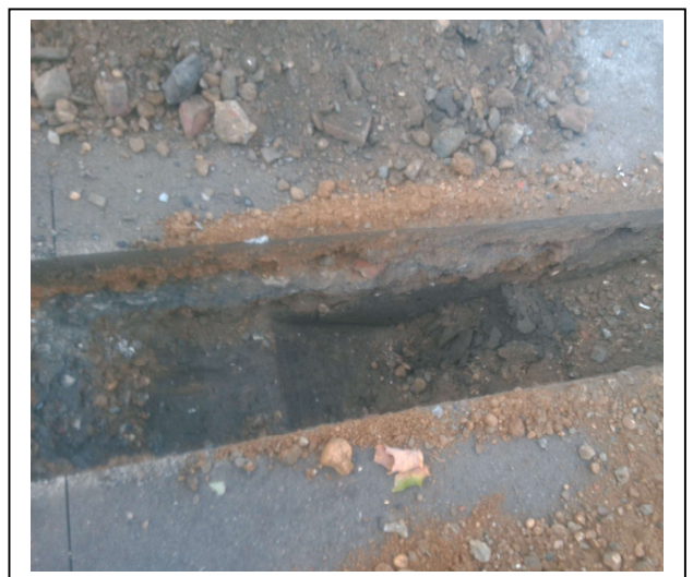
Foto 18. Sleuf D2.05 (20-50 cm -mv)
