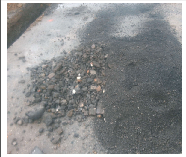
Foto 1. Sleuf D1.01 (10-40 cm -mv)
