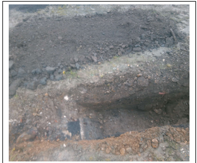
Foto 6. Sleuf D1.03 (0-20 cm -mv)
