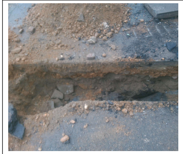
Foto 8. Sleuf D1.04 (30-60 cm -mv)
