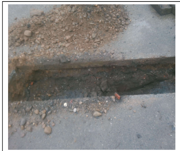
Foto 10. Sleuf D1.05 (30-50 cm -mv)
